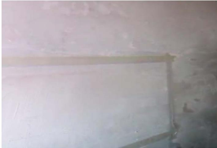
После того как поверхность достаточно выровнена, необходимо прогрунтовать ее. Для этого обязательно используется стандартная грунтовка глубокого проникновения. Ее наносят в 2-3 захода с перерывом в 3 часа между ними. И только после этого можно приступить к нанесению специальной, более густой, шпаклевки под жидкие обои. Можно для этого также использовать водоэмульсионную краску, даже фасадную. Обязательно белого цвета, без добавления колеров.
