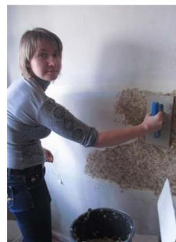
Слой в толщину должен быть не более 3-х миллиметров. Наносить на стену жидкие обои необходимо небольшими пяточками, постепенно добавляя новые порции к уже нанесенным.
