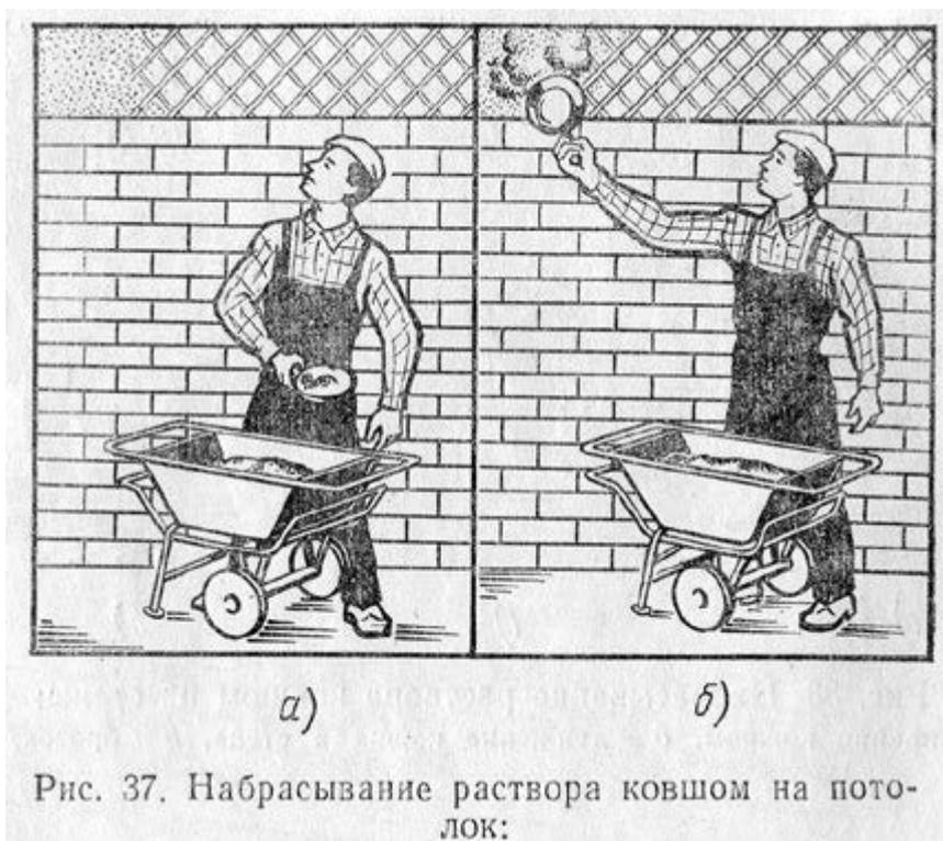
Рис. 37. Набрасывание раствора ковшом на потолок:
