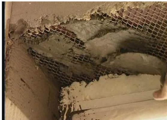
После того как обрызг на боковых откосах затвердеет или схватится, на него наносят грунт. Раствор для грунта приготавливают несколько гуще, чем для обрызга. Подвижность процеженных штукатурных растворов в момент их нанесения должна соответствовать погружению стандартного конуса в пределах 7-9 см .
