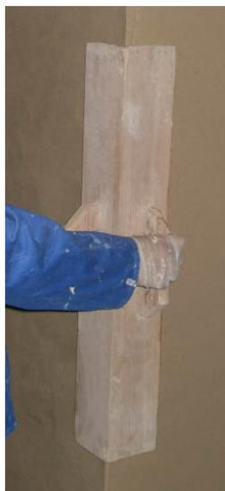
Усёнок – наружный угол, образованный между стеной и откосом. Усёнки выполняют полутёрами и используют растворы, приготовленные на мелко просеянном песке. К нанесённому раствору прикладывают полутёр, передвигая его с небольшим нажимом вверх и вниз, натирают до получения точной чистой линии усёнка (слайд «натирка усёнков»)
