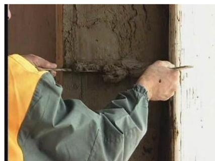
При оштукатуривании откосов их можно затирать вкруговую или вразгонку. Затирка вкруговую выполняется следующим образом. Одной рукой берут тёрку, прижимают плотно к поверхности штукатурки и делают круговые движения против часовой стрелки. Затирку вразгонку выполняют так. Тёрку, хорошо очищенную от раствора, плотно прижимают к поверхности и начинают производить ею прямолинейные движения – взмахи. Таким образом устраняют все следы от затирки вкруговую. (слайд «атирка поверхности»)
