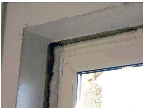
После этого необходимо срезать выступающую пену и заклеить поверхность рамы или коробки малярной лентой, для того чтобы в процессе работы не испачкать её (следующий слайд «подготовка поверхности»).
