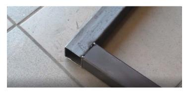
Даем отметки середины длины столешницы устанавливаем и прихватываем элемент усиления.
