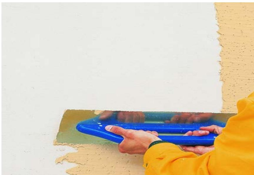
Для работы **используются различного размера шпатели** – большой для распределения смеси по стене, шпатель меньшего размера для забора состава из лотка и для удаления излишек материала или подтеков.
