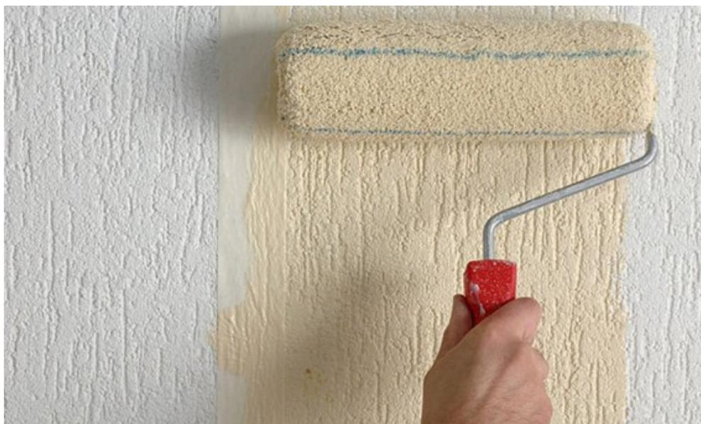
Прежде чем покрасить штукатурку, **нужно выждать как минимум сутки** после нанесения состава. В сравнении с колеровкой смеси в процессе замешивания, завершающая покраска имеет свои плюсы. Например: **удобней ровнять стену после высыхания краски**, в то время как колерованный состав сложнее поддается воздействию и оставляет видимые следы затирания.
